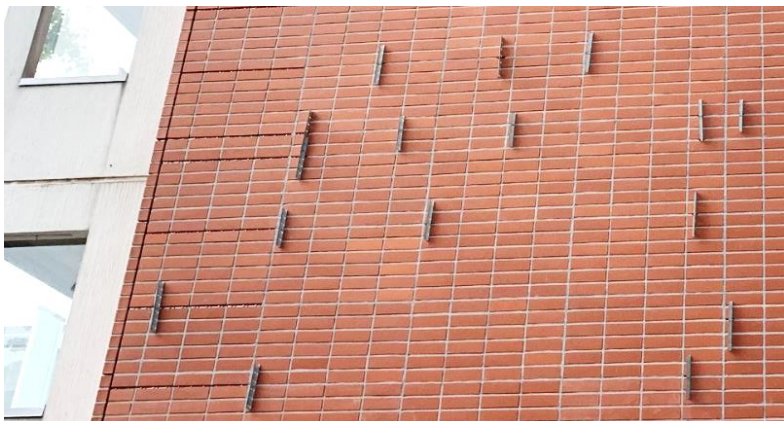
Bild 34: Kontrollera panelytans jämnhet innan fogningen
