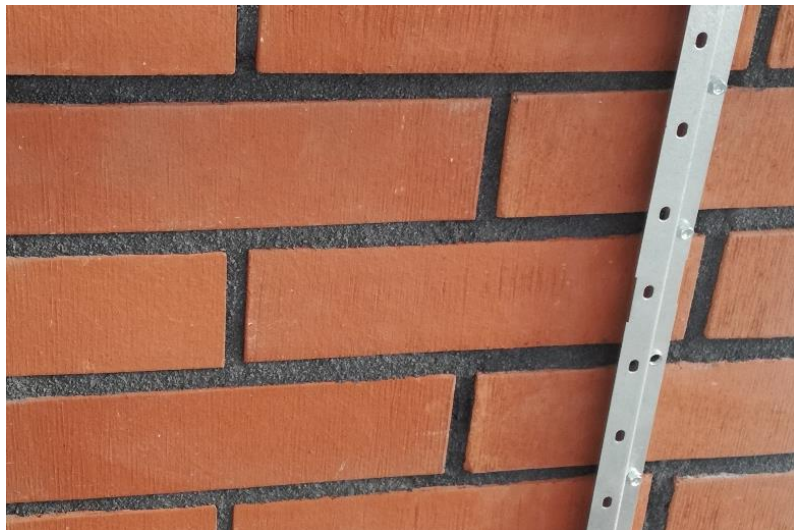
Bild 37: Stödskena för utbytt tegelplatta
