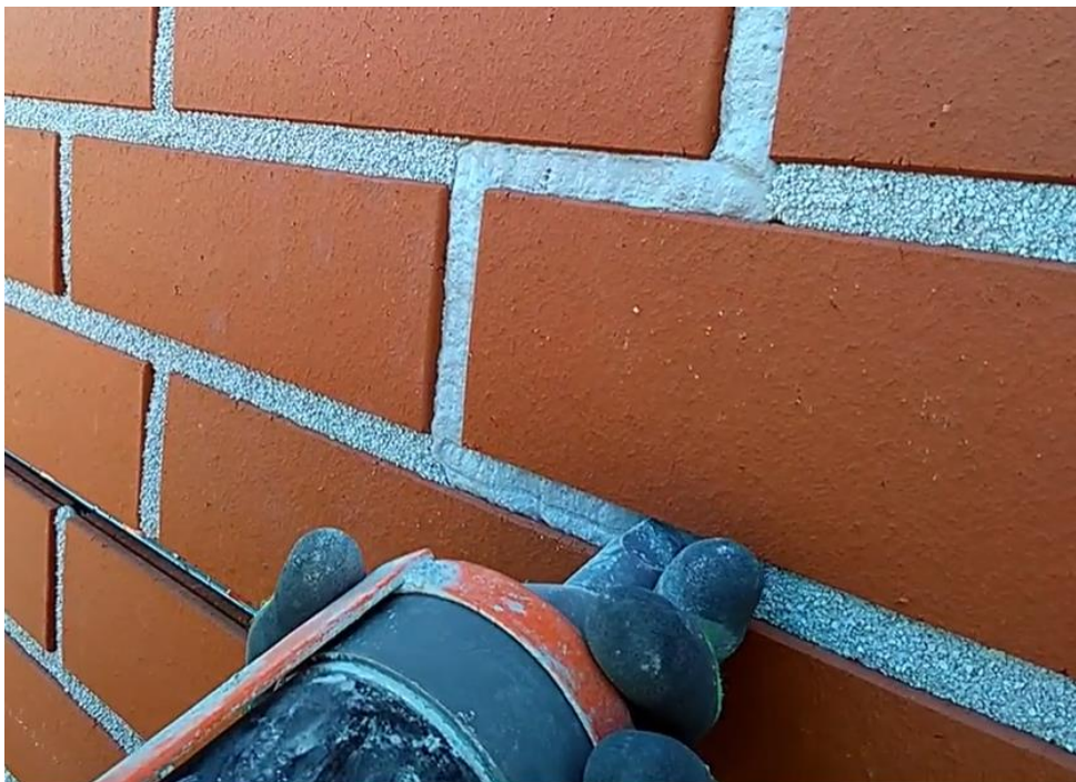
Bild 41: Fogning på arbetsplatsen
